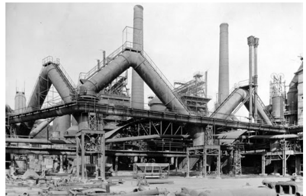
Figure 2 : L'usine de Pompey. Noter les énormes tuyaux à 45° de la verticale. Ils servent à récupérer les gaz de combustion des fourneaux (4 à Pompey) et sont inclinés pour éviter leur colmatage par la poussière, surabondante.
